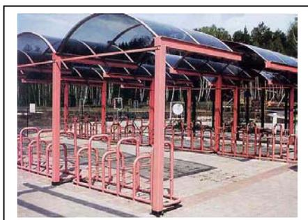
Le système de « pince-roue » sera abandonné, il voile les jantes et n'assure pas la sécurité face au vol.
