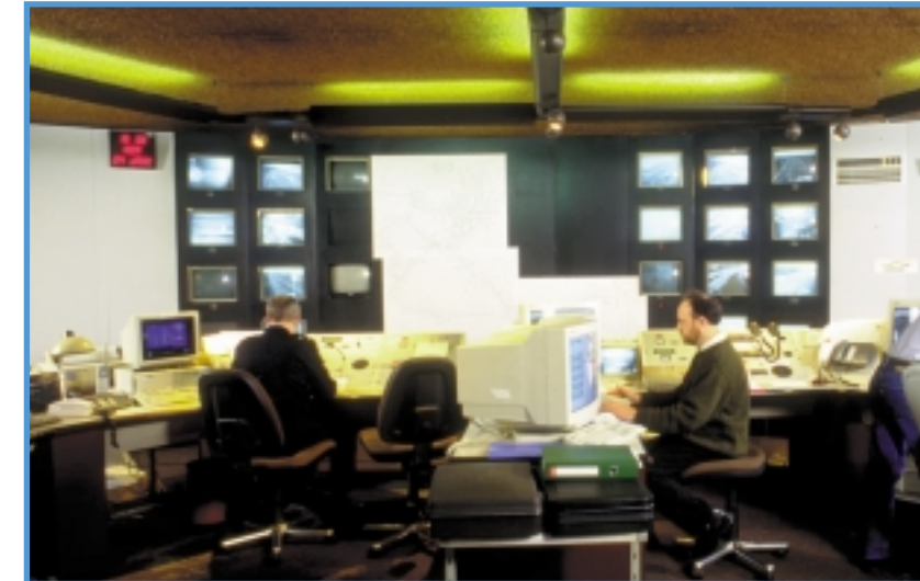
Intérieur du poste de contrôle sud à Arcueil
