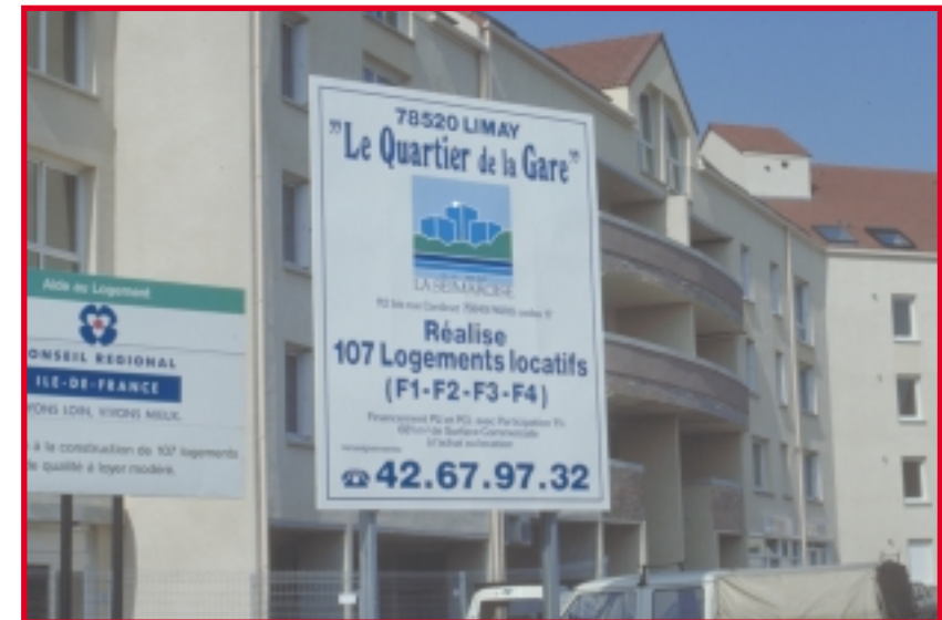
Logements collectifs en construction près d'une gare de grande banlieue
